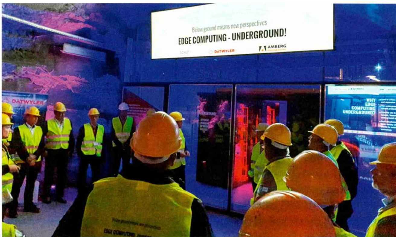
Im Versuchsstollen Hagerbach in Flums wurde im September der Prototyp eines modularen und für die Platzierung im Untergrund entwickelten Rechenzentrums präsentiert. Bild: Amberg Engineering AG/Dätwyler Cabling Solutions AG
